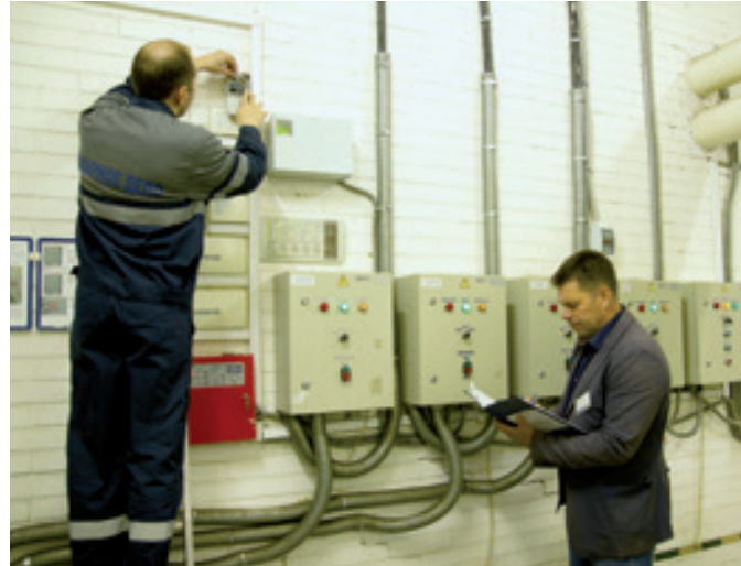
Настройка системы пожаротушения. 2018 г.
