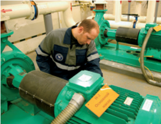
Проверка оборудования насосной станции пожаротушения. 2018 г.
