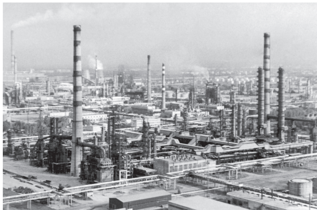
Панорама Омского нефтеперерабатывающего завода. 1970-е гг.
