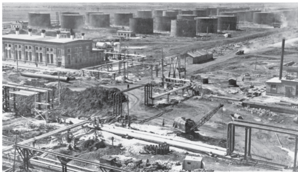
Строительство Омского нефтеперерабатывающего завода. Начало 1950-х гг.
