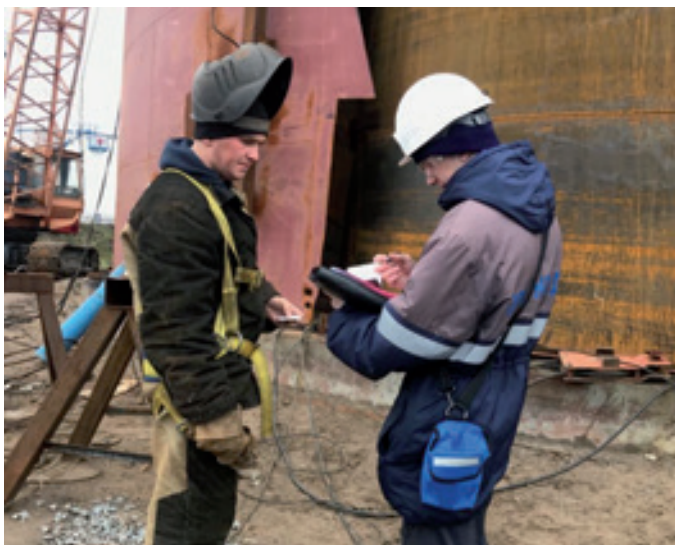
Проверка документов у газосварщика для проведения огневых работ
